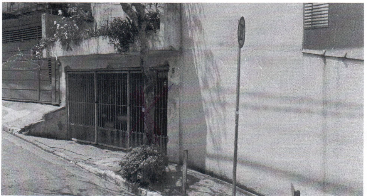
Rua Golden Park, 22 - Bairro Montanhão
