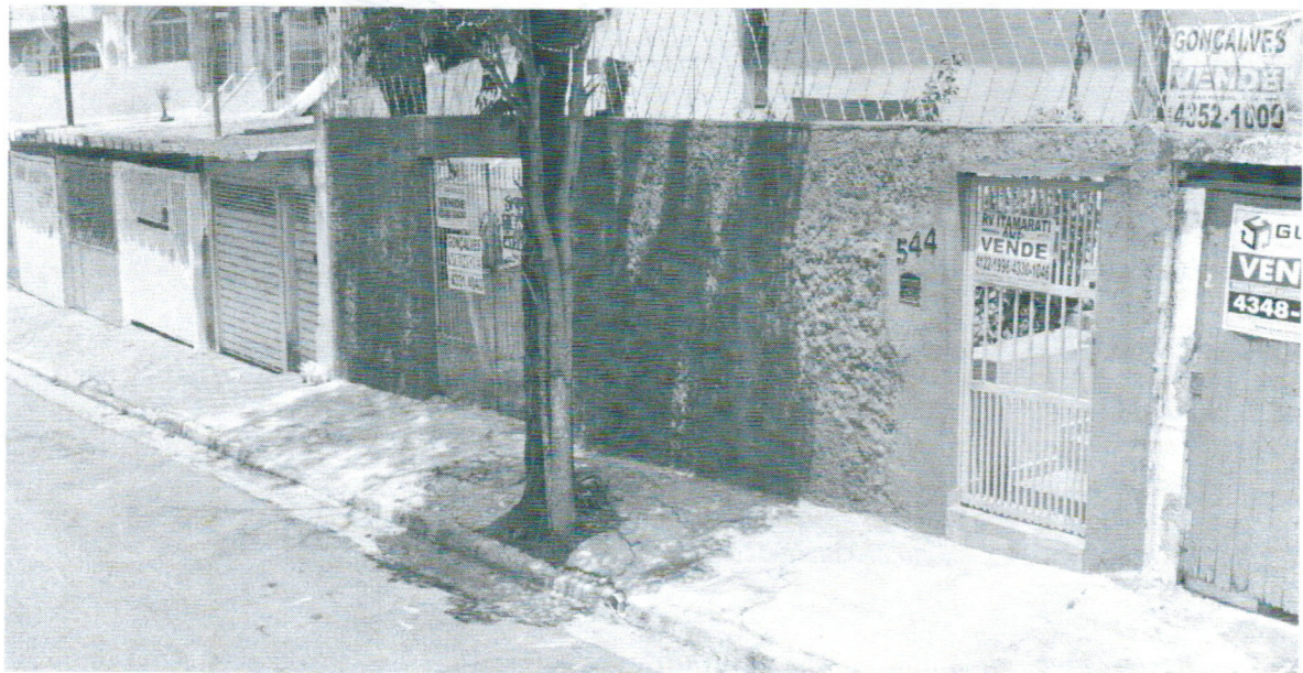
Rua Bauru, 544 - Bairro Baeta Neves
