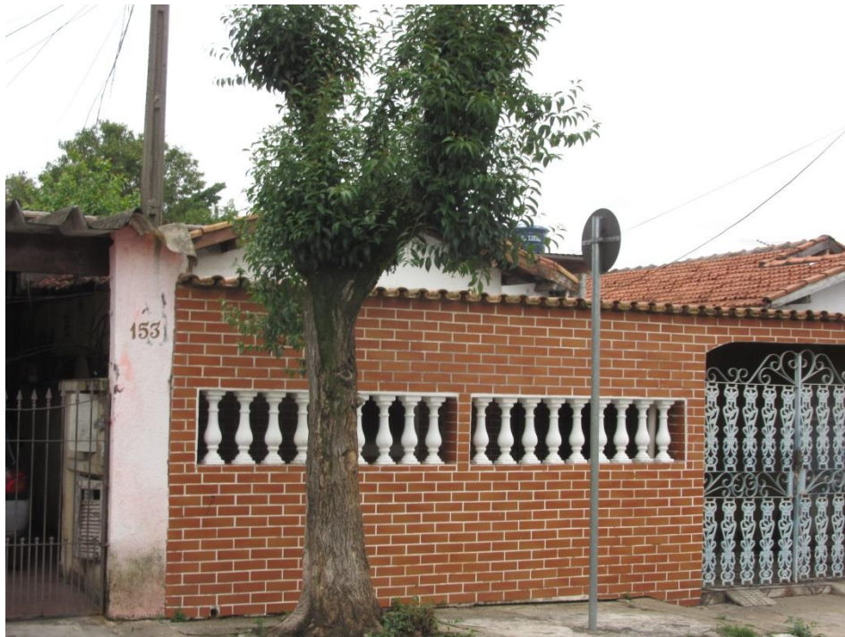
Fotos 1 a 2 – Rua Botucatu, 153 - 161 - Bairro Jordanópolis – SB. 024401 – 2021 -32-Subst. Grave Em.
