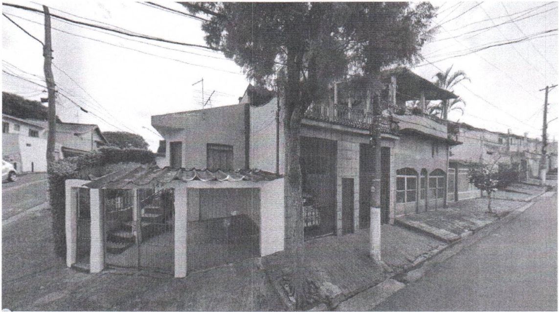
Rua Angelo Pessotti, 543 Bairro Assunção VCSBC substituição
