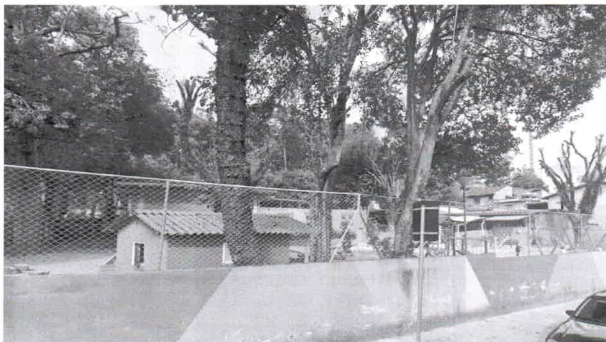
Rua Braga, 20 - EMEB Rui Barbosa - B. Centro
