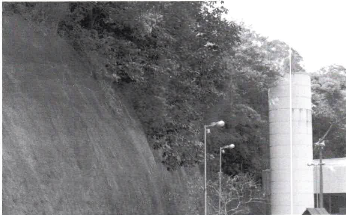
Estrada do Vergueiro, 201 - EMEB Lorenzo Eurico Felice Lorenzetti – Vila Bauneária
