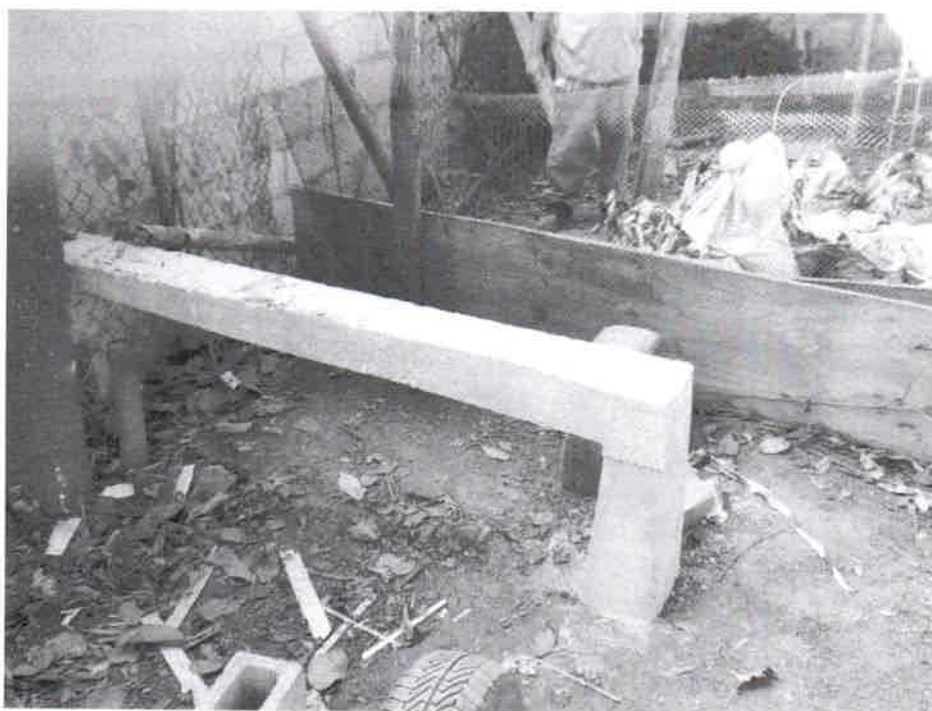
FOTOS 06,07,08 DAS MÃOS FRANCESAS REFORÇO NO MURO DE ARRIMO COM BROCAS DE 2:50 DE PROFUNDIDADE E ALANCA EM CONCRETO ARMADO COM AÇO 10,0MM
