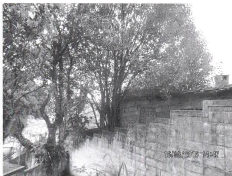
Foto 1 a 3 – Rua Dom Fernando Mascarenhas, 44 – EMEB Antonio de Lima – Remoção – SBC 91025960
