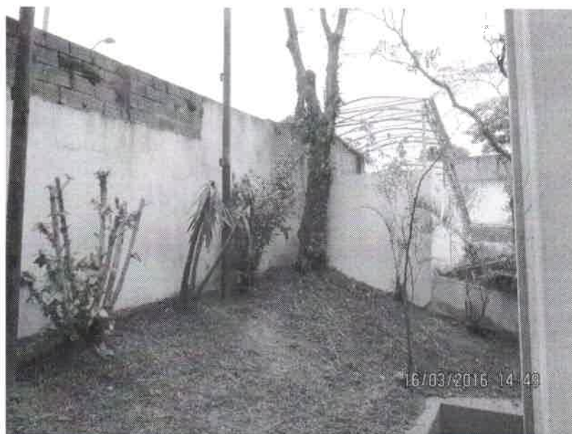
Foto 1 a 3 – Rua Dom Fernando Mascarenhas, EMEB Antonio de Lima – Remoção – SS 170412/16.
