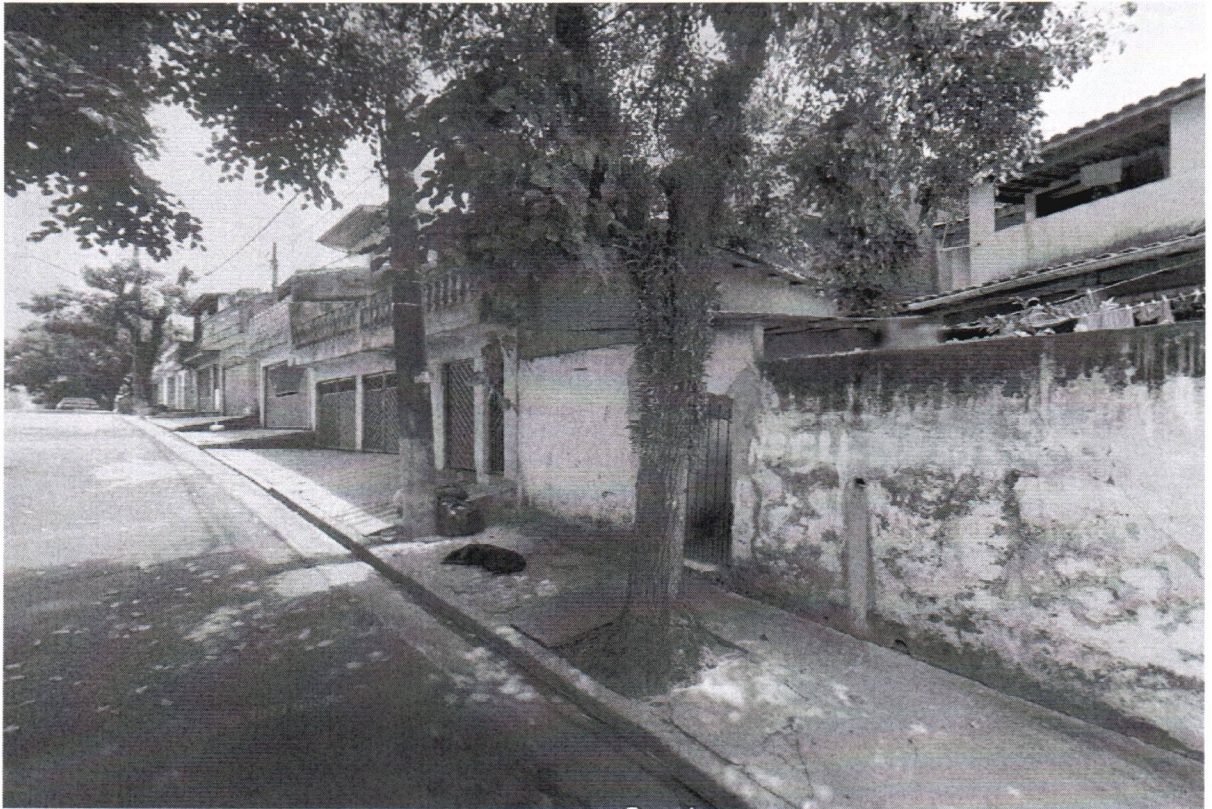
Rua Dos Èbanos ao lado nº 135 - passeio público da Rua Dos Pinheiro, 54 - B. Dos Casa
